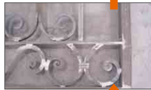
•加工箇所仕上がり確認
